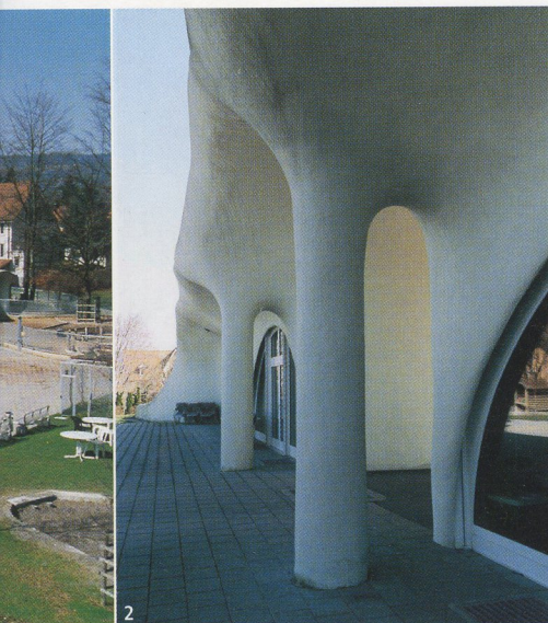
2 東横キャンピー。柱と庇・建物が一体となっている 3 東棟正面外観。
